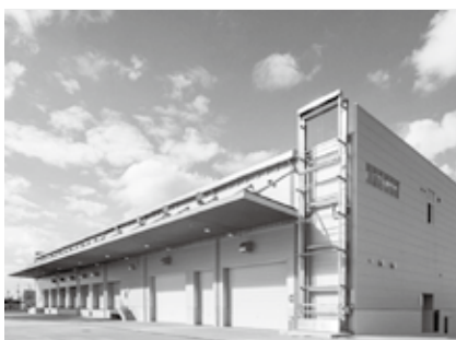
大規模災害時の対策拠点施設
