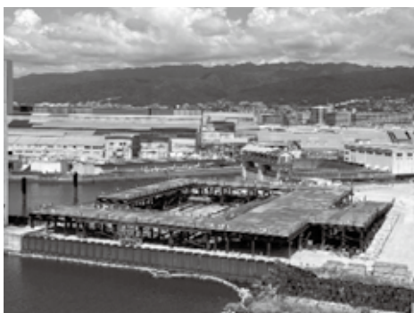
排水機場本体を建設中
