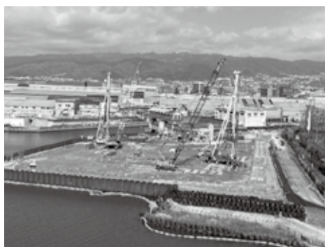
たくさんの大型重機が稼働しています
