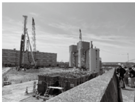
工事現場を間近で見学
