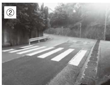
コープから上がって来て①の次のカーブ。カーブで横断歩道に気づきにくい
