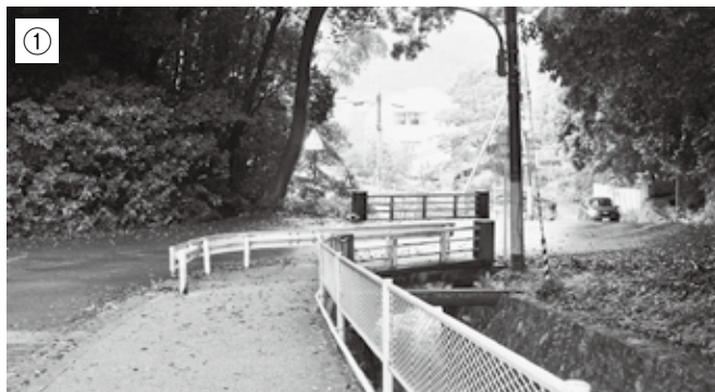
写真手前は歩道が右側、橋を渡ると歩道が左側になります。橋を渡った所に横断歩道があり、しかも急なカーブ。事故がないのが不思議です
