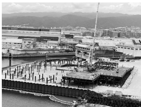
排水機場の工事状況
