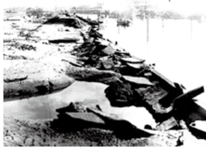
破壊された鳴尾川の堤防
