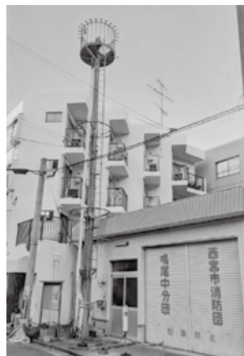
鳴尾支所北側に残る唯一の火の見櫓
