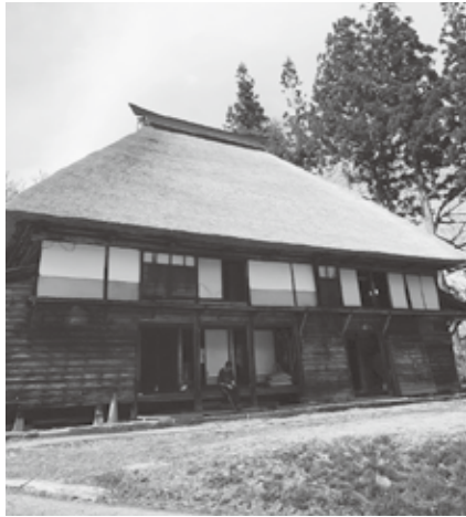
カブ隊が泊まる古民家
