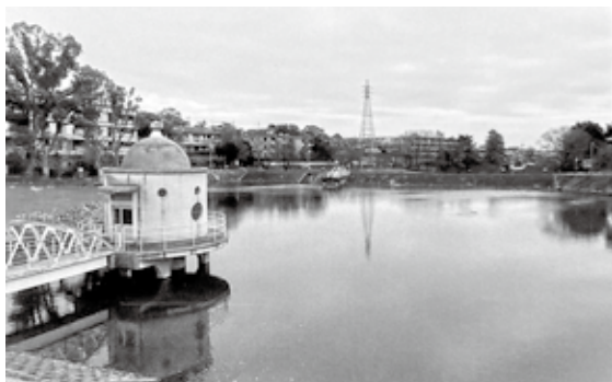
ニテコ池のシンボルの取水塔
