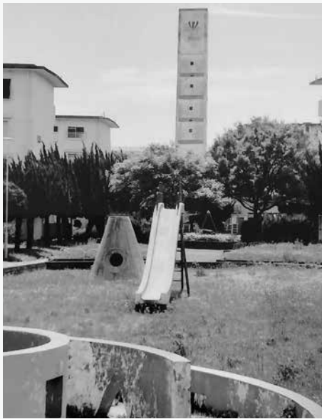
撤去された給水塔
