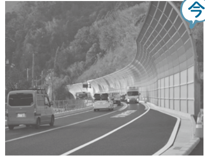
⑮新しく完成した名塩道路。車道と歩道を区切る防音壁が立てられています。生瀬で初めて防音壁に守られた国道176号沿いの歩道ができました
