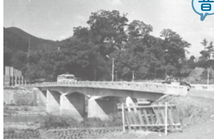
③昭和30年ごろの生瀬橋。今も阪急バスはこの橋を通ります。宝塚へ行く武庫川沿いには松が植えられ、通称「愛の松原」と呼ばれていました
