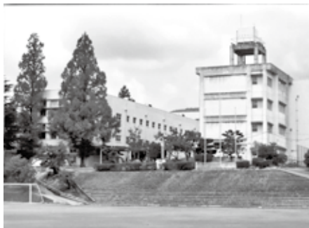
下段グラウンドから校舎を見上げる
