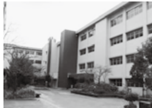
校舎の外壁塗装完了 12月末 昨年度から続いていた外壁塗装工事が完了。ひさしや柱に強調色が施され、地域の景観にマッチしています
