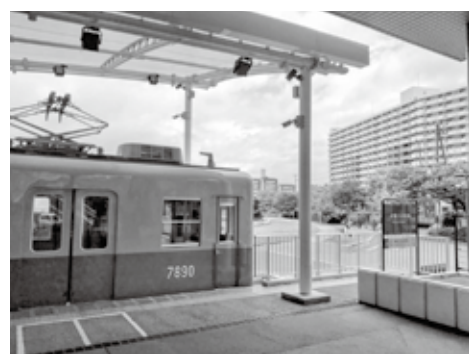
「赤胴車がある広場」の赤胴車 小曽根線を挟んで向こう側に1号棟
