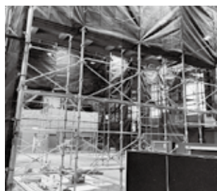
エアコン工事 夏休み中 体育館のエアコン工事の様子。10月から使えるようになりました
