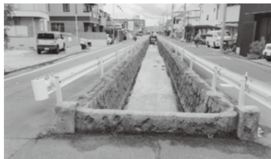
本郷学文筋の水路は暗渠化工事中です(戦時中の爆弾の痕跡が残る橋)
