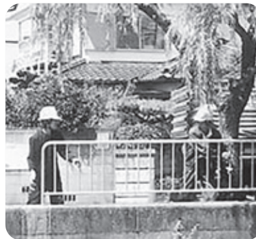
安全柵取り付け工事
