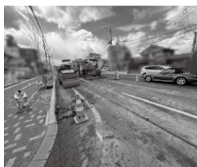
工事風景 (4月半ばに天道町で撮影)
