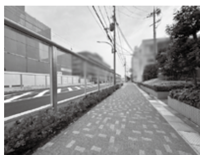
防音のためのアクリル板が設置されている様子 (7月初旬に二見町で撮影)
