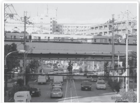
高架になった西開踏切
