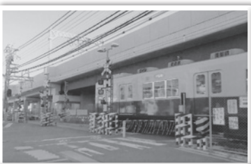
⑥小曾根線西開踏切・下り線が高架化
