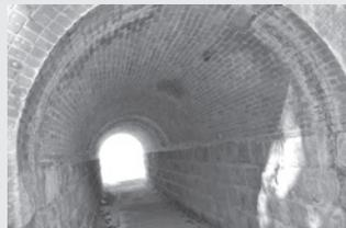
大仏鉄道築堤の際、農道や水路を通すために設けられた隧道。アーチ部分のレンガは長手積み、坑門はイギリス積みで、当時の技術の高さが分かります。内部を歩くことができます。
