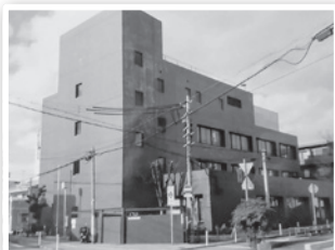
⑧鳴尾支所新庁舎
