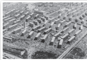
③建設中の浜甲子園団地
