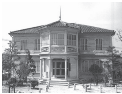
公民館として使用されていた頃の六角堂(昭和38年)
