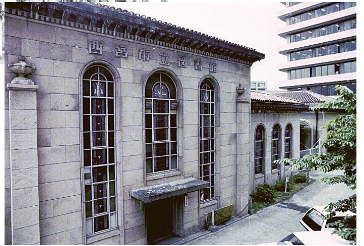
取り壊し直前の西宮市立図書館
