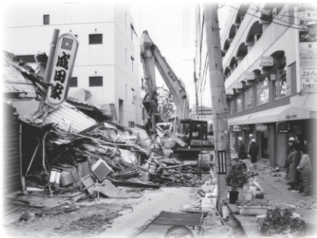
夙川グリーンタウン東側
