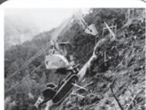
高所法面掘削機を使用予定
