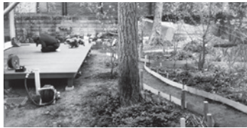
ウッドデッキと小道をつくっています
