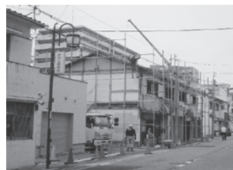
突き抜けるクレーン
