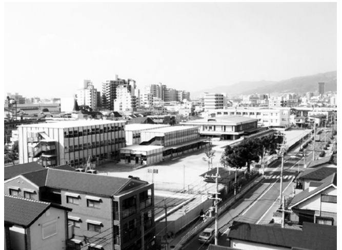
工事中の仮設校舎
