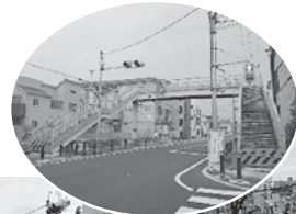
昭和43(1968)年に設置された歩道橋も撤去
