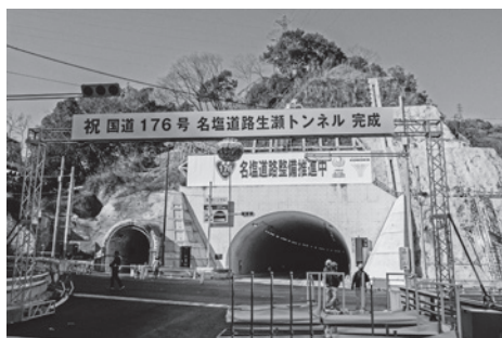
2月13日、交通切り替えを待つ生瀬トンネル
