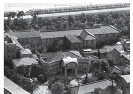
昭和30年代の西宮回生病院 (写真：西宮回生病院提供)
