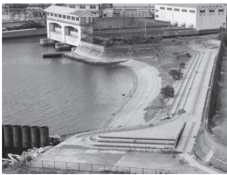
すでに工事が始まっている今津浜
