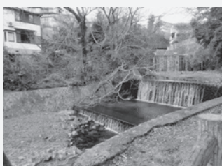
上流の越木岩えん堤と段差
