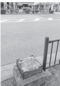
鉄柱基礎台跡
