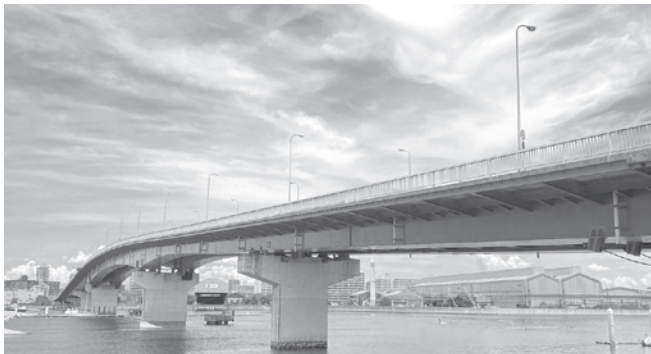
元旦には橋の上から初日の出を見ることができます
