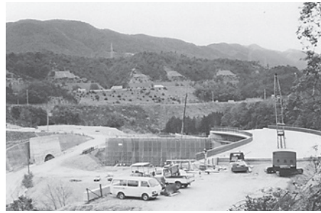
上部山裾が埋め立て中の鹿戻し。手前は建設中の名塩新橋です(昭和50年代中頃撮影)
