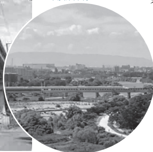
高架橋をハシる山陽新幹線
