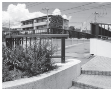
平成7年に完成した雲井橋横に架けられた歩道橋
